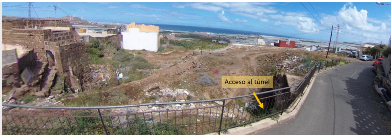
Ilustración 3. Acceso al túnel. Elaboración Propia.
