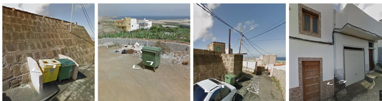
Ilustración 15. Degradación de la imagen urbana.
