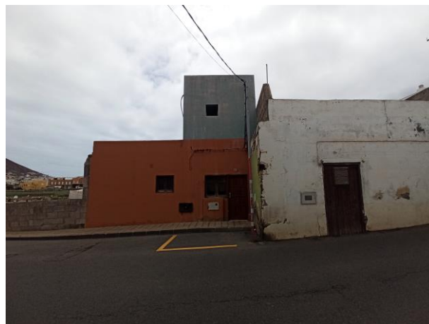
Vivienda 2. Estrechamiento producido por la vivienda 1.
