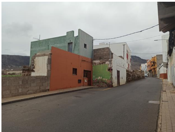
Vivienda 2, en su encuentro con la vivienda 1.
