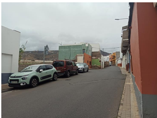
Vista de la fachada afectada por la MM en sentido sur.
