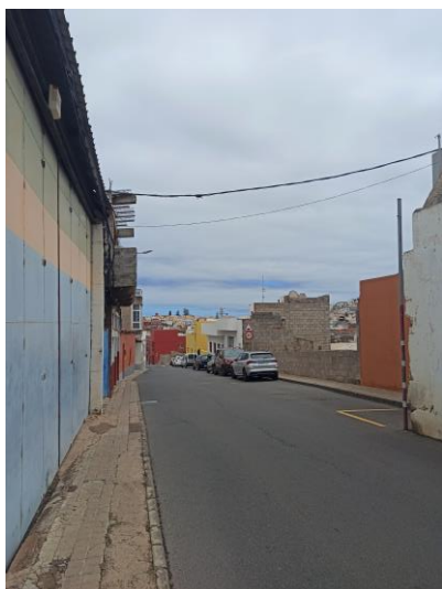
5. Pavimentación de calzada.
