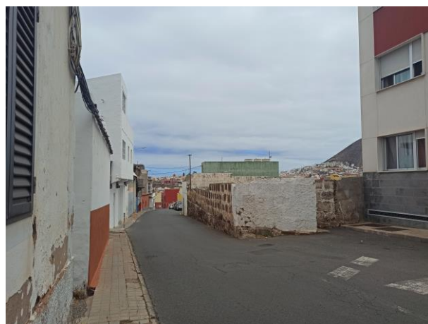
Vista de la fachada afectada por la MM en sentido norte.
