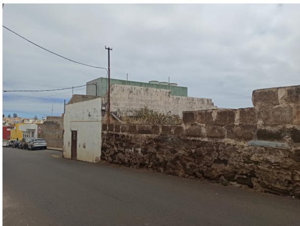
Vivienda 1 y muro del estanque.
