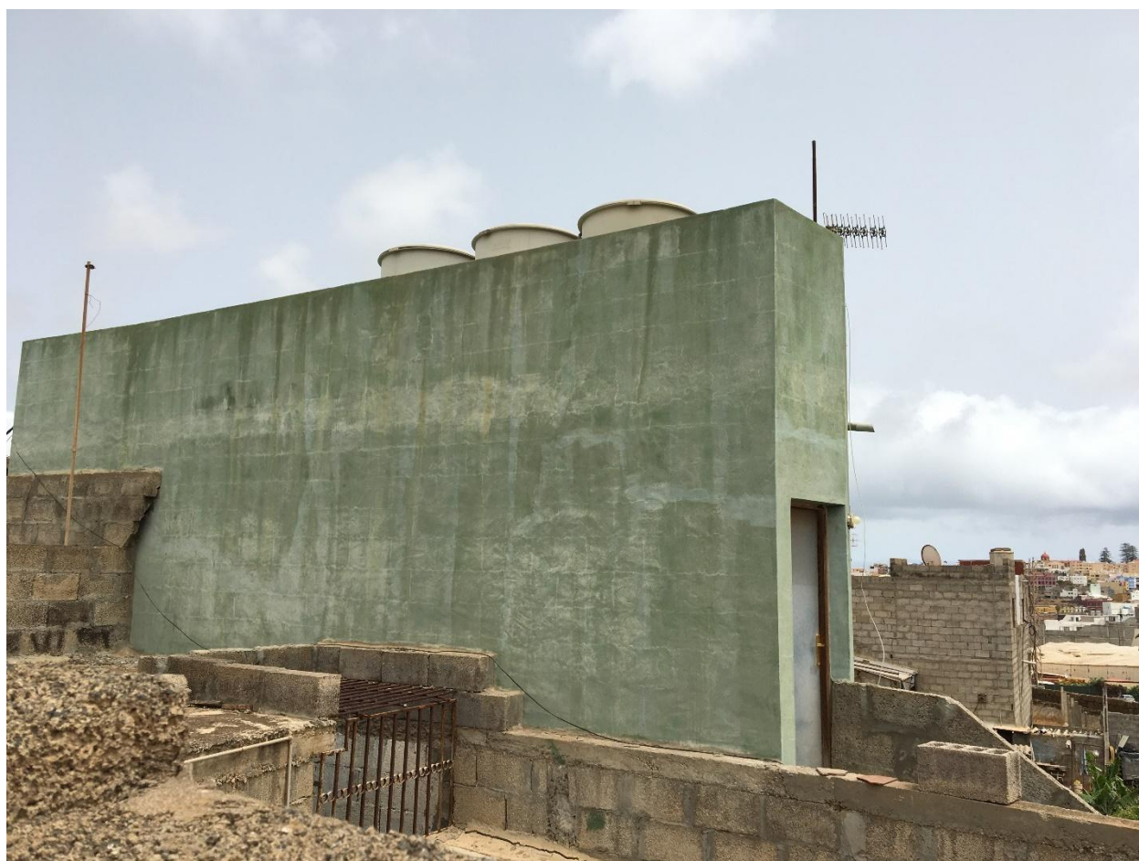
Figura 18 Construcciones localizadas en la parcela que presentan un tratamiento inadecuado de fachadas, así como un notable deterioro estructural y una escasa integración paisajística. Fuente: Elaboración propia.
