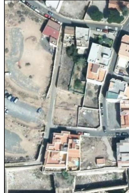
Estado actual en el área concreta afectada por el ED. Ortofoto.
