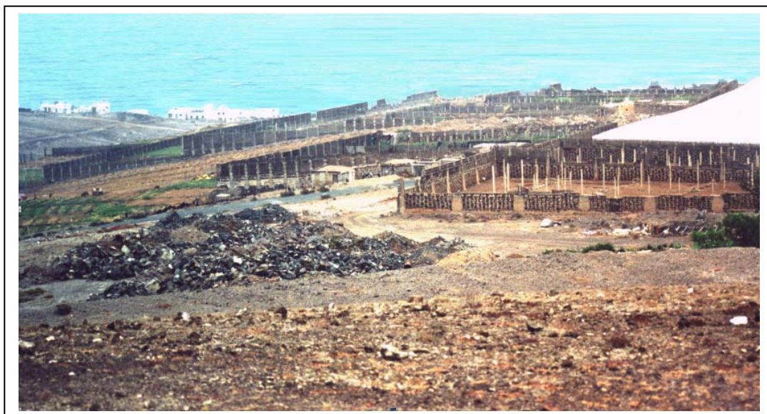
Invernaderos abandonados en la zona de Sardina, con la consiguiente dismantelación que sufren los mismos, la pérdida de tierras de labor y el amontonamiento de escombros y basuras varias.
